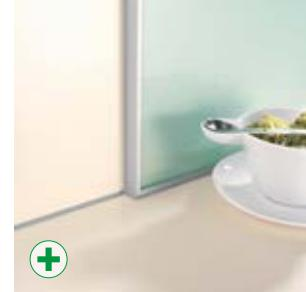
**Kontrollieren Sie regelmäßig die Silikon-Abdichtungen entlang der Rückwände, rund um die Spüle und bei Aufsatzschränken.**
