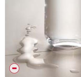
**Auf den Stoßfugen der Arbeitsplatten keine Blumentöpfe, Kaffee- oder Espressomaschinen, Wasserkocher und ähnliche Geräte abstellen, bei denen die Gefahr des Überlaufs besteht. Verschüttetes Wasser dort gleich abwischen.**
